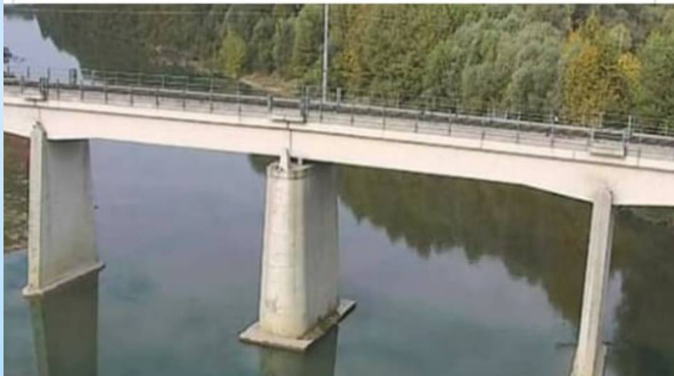
Ponte ferroviario sul Fiume Piave (Ponte di Piave TV)
