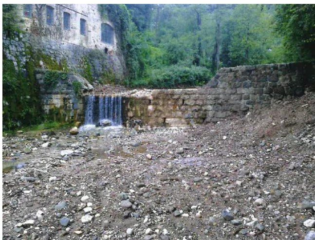
Briglia di cui è prevista la sostituzione
