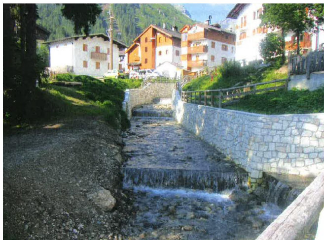
Collegamento con Il muro esistente di monte
