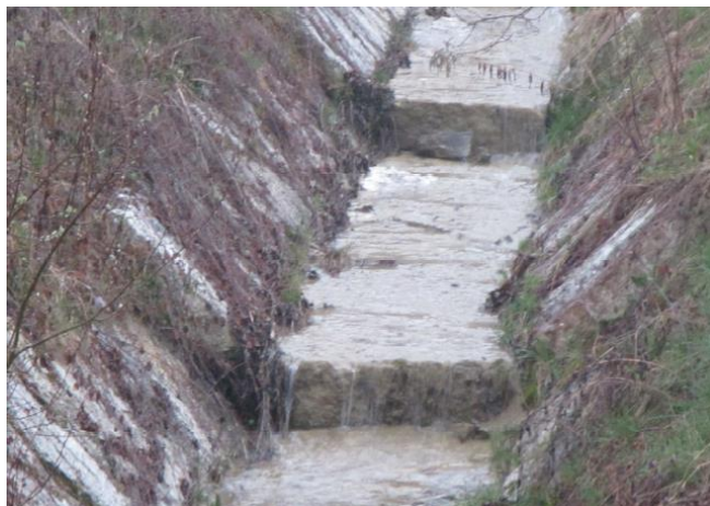
Esempio di canale in grosse pietre e malta cementizia
