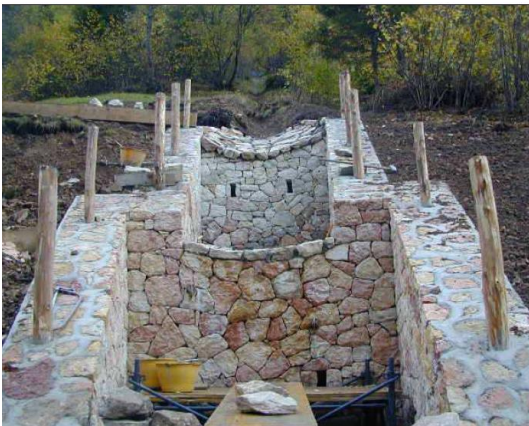
Opere in muratura
