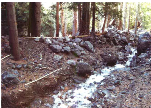
Rio Scur dove si prevede il ripristino della sezione di deflusso
