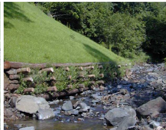
Rinverdimenti e consolidamenti dei versanti
