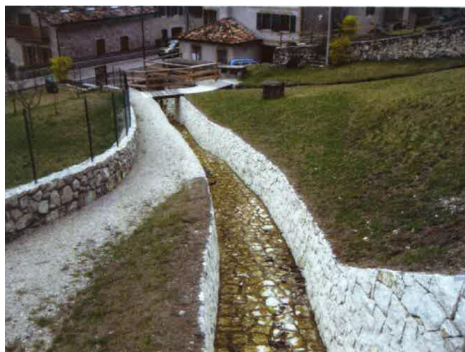
Tratto di canale con rivestimento in sassi a faccia vista che precede il nuovo tratto che verrà realizzato con le stesse modalità e caratteristiche architettoniche
