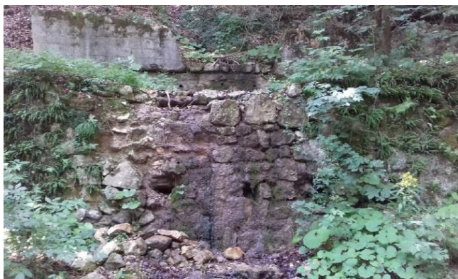
Muro da demolire
