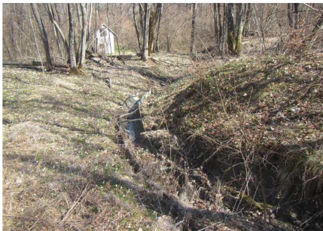
Loc. Carbonil canaletta in acciaio ondulata da sostituire
