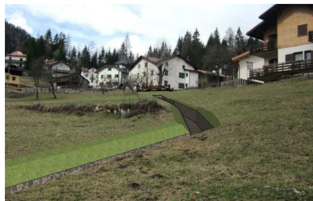
Zona del Ru Negher dove è prevista la briglia sinusoidale con vasca sghiaiatrice, e simulazione dell'opera.
