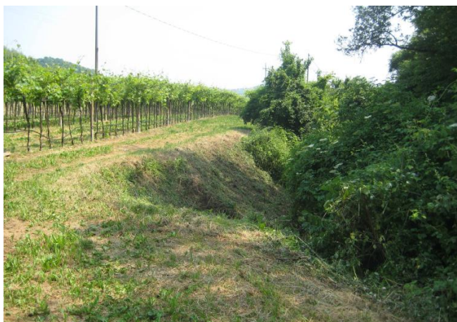
Mezzane di Sotto – Loc. Gugi, Valle Birancolo – dettaglio sulla frana che sarà rimodellata e stabilizzata al piede mediante una palificata a doppia parete.
