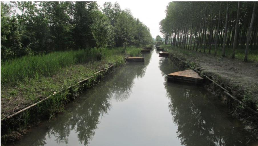
Fiume Sile tratto rettificato nel 1944, interventi di rinaturalizzazione di evidente impatto, incongrui con i valori paesaggistici riconosciuti.
