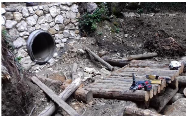
Briglie in legname e pietrame esistenti nella stessa Valle e della stessa tipologia di quelle in progetto.
