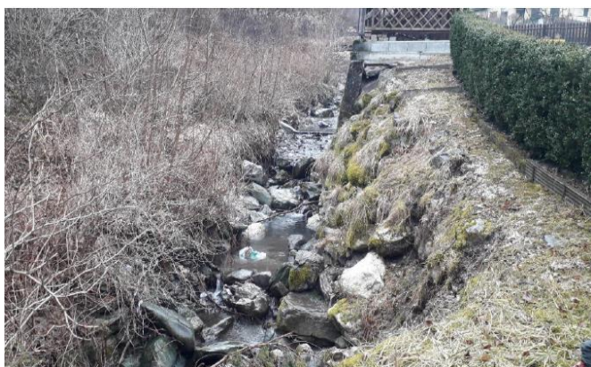
Zona dove è prevista la realizzazione del muro d'argine in c.l.s
