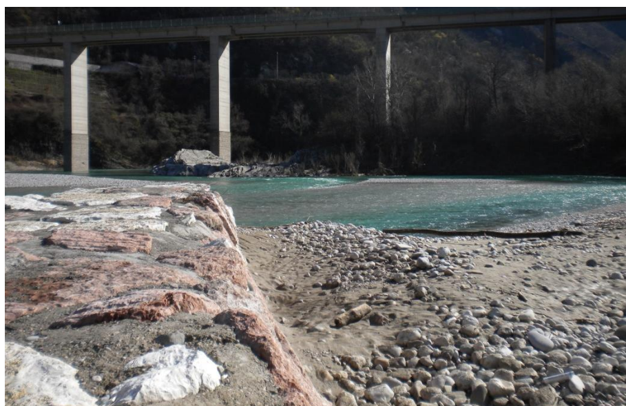
Fiume Piave – opere di difesa spondale con repellenti in roccia intasata, necessari per porre in sicurezza le infrastrutture stradali e ferroviarie. Si sarebbe potuto evitare il completo affogamento della roccia, mantenendo le superfici a vista con aspetto prossimo alla posa a secco.
