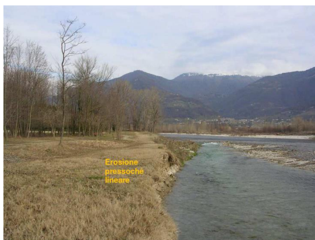
Sponda dx in erosione ripresa da valle
