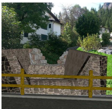
Zona del Ru Negher dove è prevista la briglia sinusoidale con vasca sghiaiatrice, e simulazione dell'opera.
