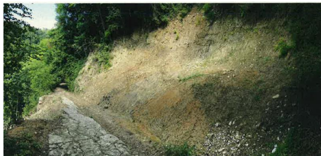
Stato di fatto a seguito evento franoso
