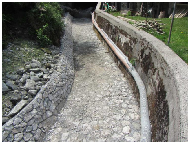
Esempio di selciatura del fondo previsto in loc. Col d’Ornella
