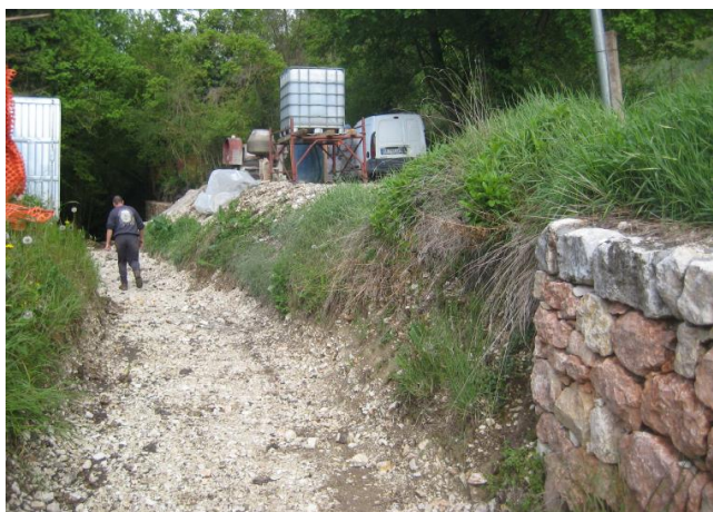
Cerro veronese – Loc. Carbonara, Vaio Caramalda– tratto in cui verrà prolungato il muro spondale a completamento delle difese spondali già realizzate nel 2015 e 2017.
