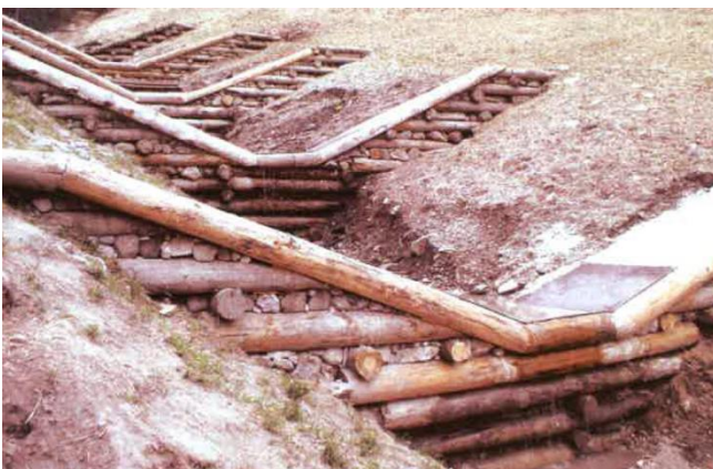
Esempio di opere miste recuperate e ripulite dal materiale litoideo analoghe a quelle previste
