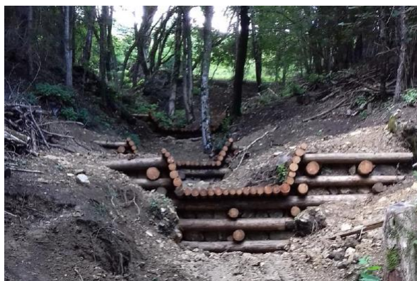
Briglie in legname e pietrame esistenti nella stessa Valle e della stessa tipologia di quelle in progetto.
