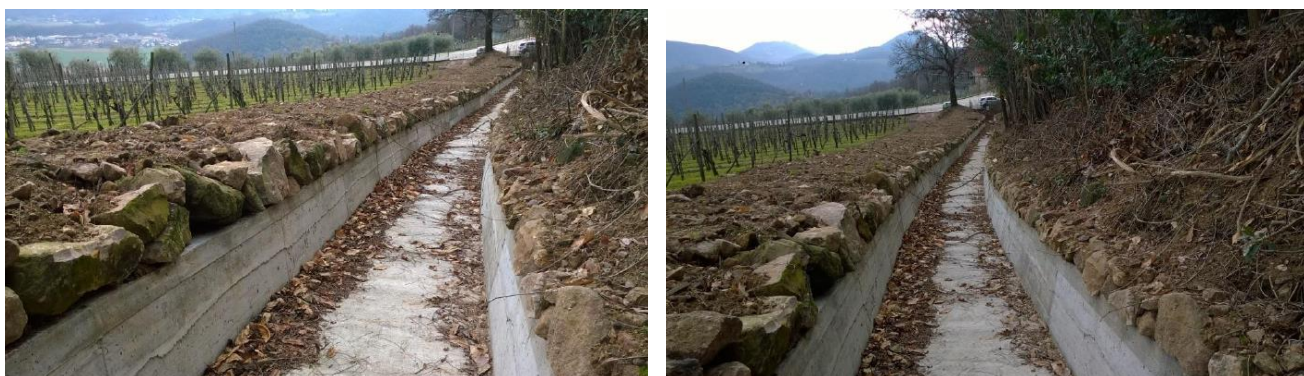
Cunettone esistente realizzato al grezzo privo di mitigazione di cui è previsto il rivestimento in trachite nel progetto.
