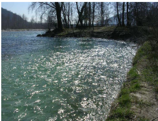
Erosione di monte
