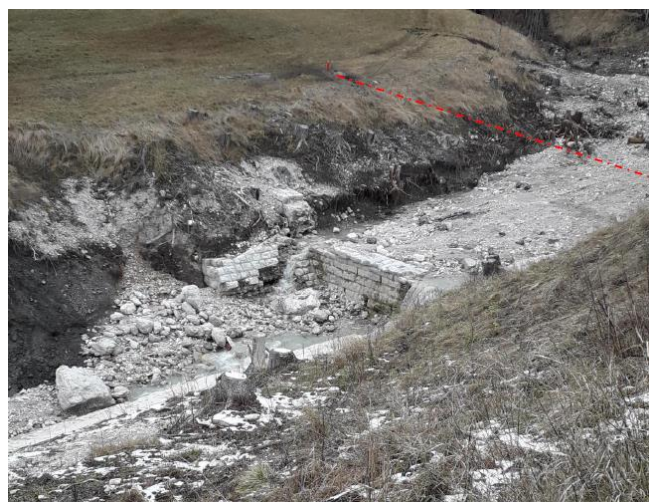
Cortina d'Ampezzo – T. Bigontina: Vista d'insieme della controbriglia esistente da rifare e della sezione d'imposta dell'opera selettiva, che si trova 13 m più a monte.
