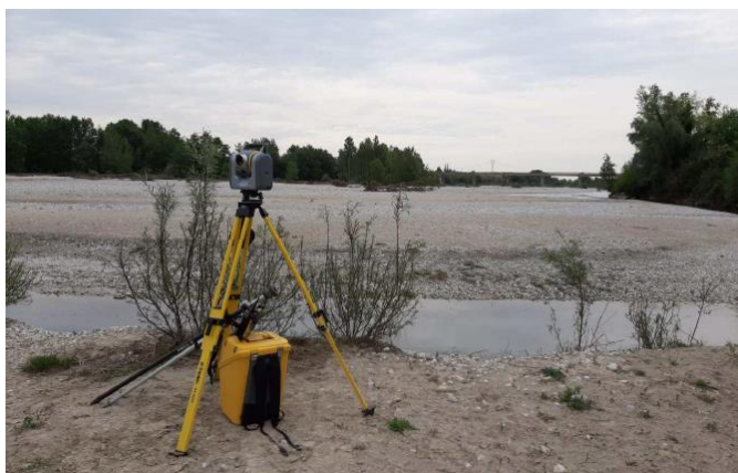
Zona di intervento per la realizzazione della "savanelle"
