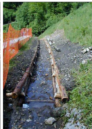
Drenaggi e canalizzazioni
