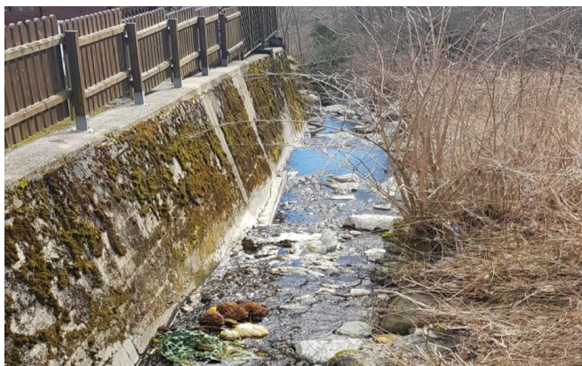
Muro esistente che si intende prolungare con le stesse caratteristiche
