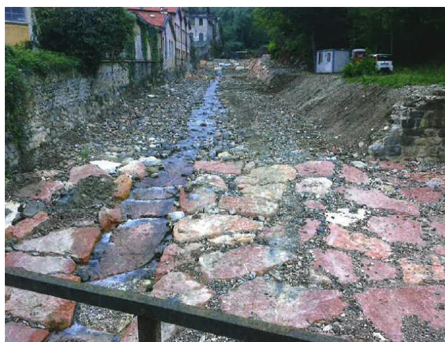
tratto interessato dagli interventi
