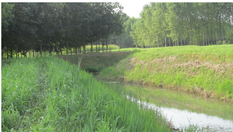
Fiume Dese, sponde arginali interne con pendenze elevate anche oltre il 100%, che rendono impossibile l'avvicinamento all'acqua e pericoloso il percorso sulla sommità arginale.
