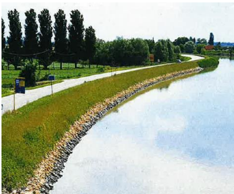
lavori analoghi eseguiti nel 2015
