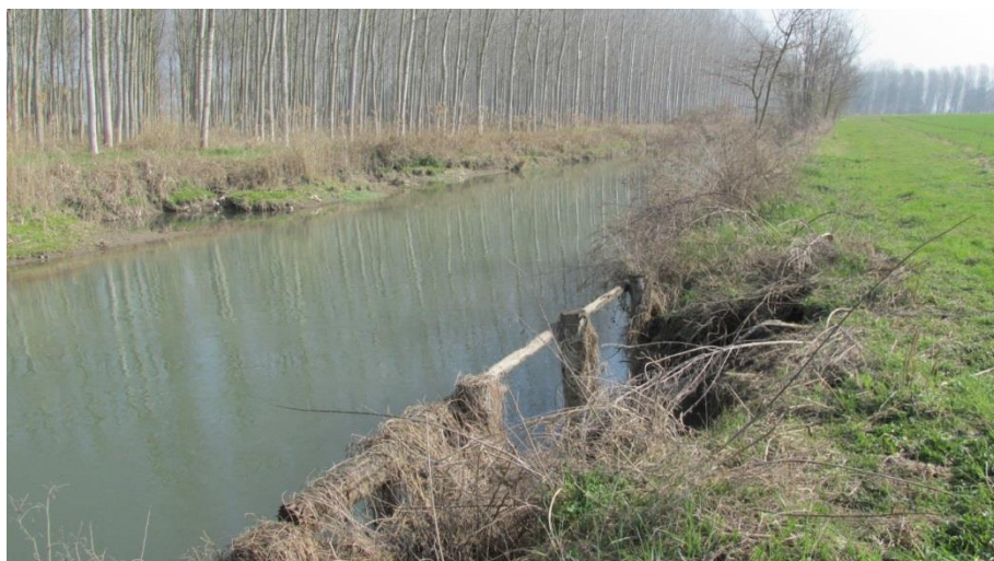
Fiume Sile in dx orografica: difese spondali inadeguate per una corretta difesa spondale, estranee ai metodi di difesa tradizionali, di pregiudizio dei valori paesaggistici rilevati e tutelati.
